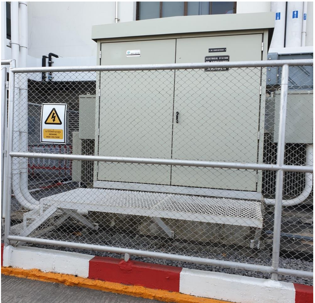
รูปที่ 34 โครงการมีการติดตั้งหม้อแปลงไฟฟ้า ชนิด Oil Immersed Type ขนาด 2,000 KVA จำนวน 2 ชุด ไว้บริเวณด้านหลังอาคารโรงพยาบาล
