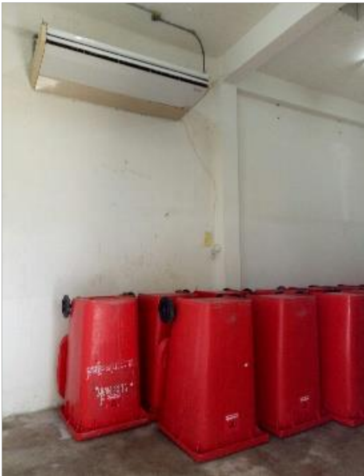
รูปที่ 68 โครงการมีการติดตั้งเครื่องปรับอากาศเพื่อควบคุมอุณหภูมิในห้องพักขยะมูลฝอยติดเชื้อ และเปิดใช้งานตลอดเวลา
